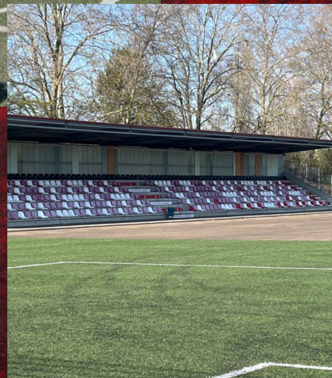
Die Tribüne verweist und der Platz schon halb abgetragen: die Arbeiten auf Platz 1 sind in vollem Gange.
